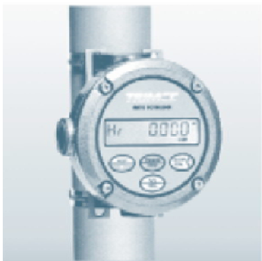
Монтаж на трубопроводе
